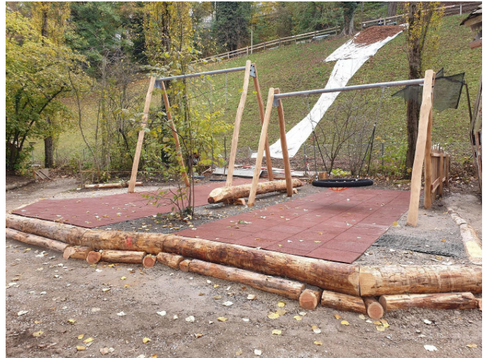
Ändlech wider rittigampfe: Ein neues Längmuur-Highlight ist geboren.
